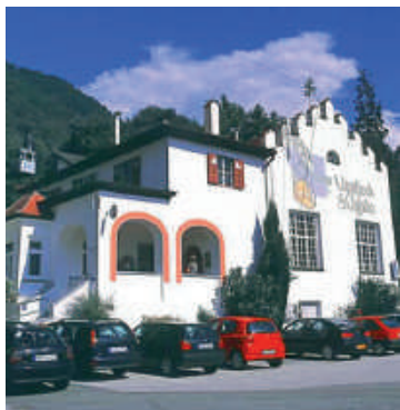
Die Talstation der Vigiljochbahn nach der Restaurierung, 2008.
