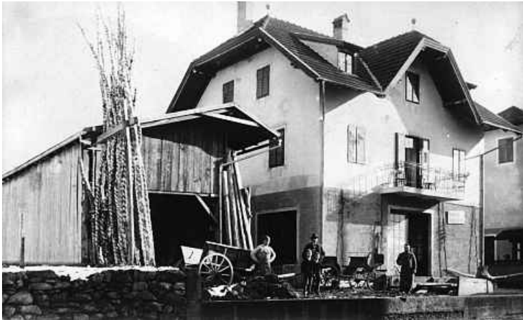
Officina e abitazione di Thomas Peer, a Terlano
