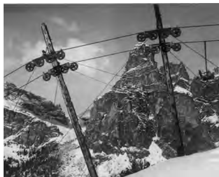
Pilastri in legno del primo impianto di risalita a Corvara
