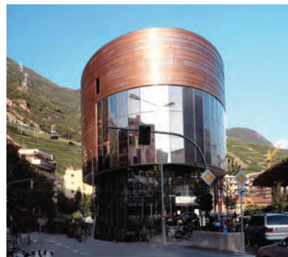
La nuova stazione di valle della funivia del Renon, Bolzano
