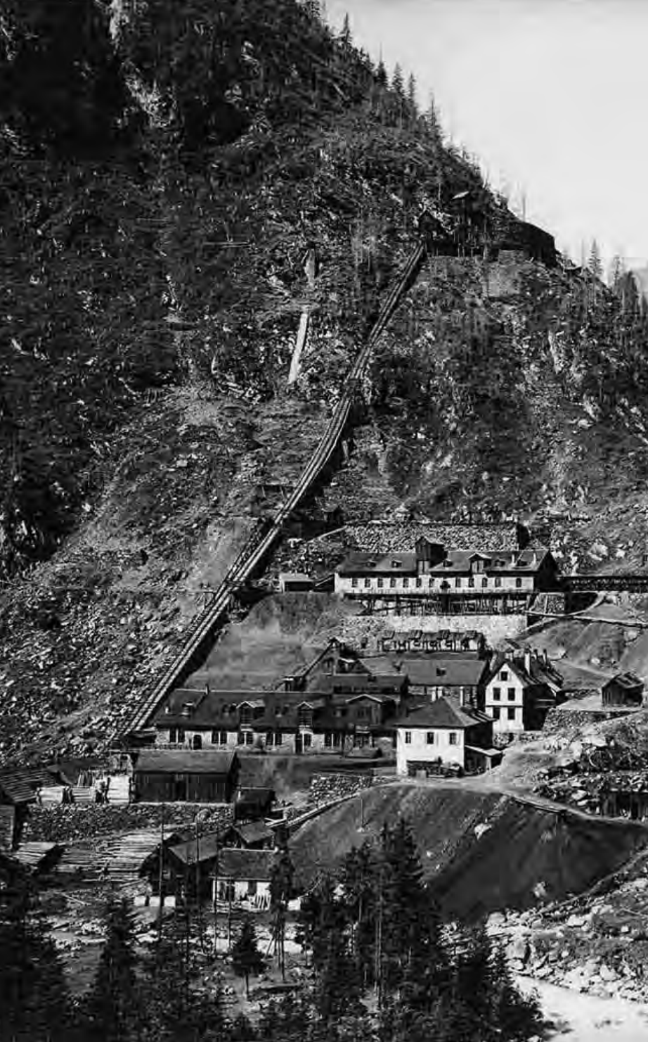
L'impianto di lavorazione a Maierm con il piano inclinato di frenata
